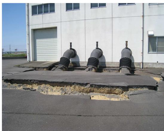
写真-12 機場の地盤沈下（新利根川）
